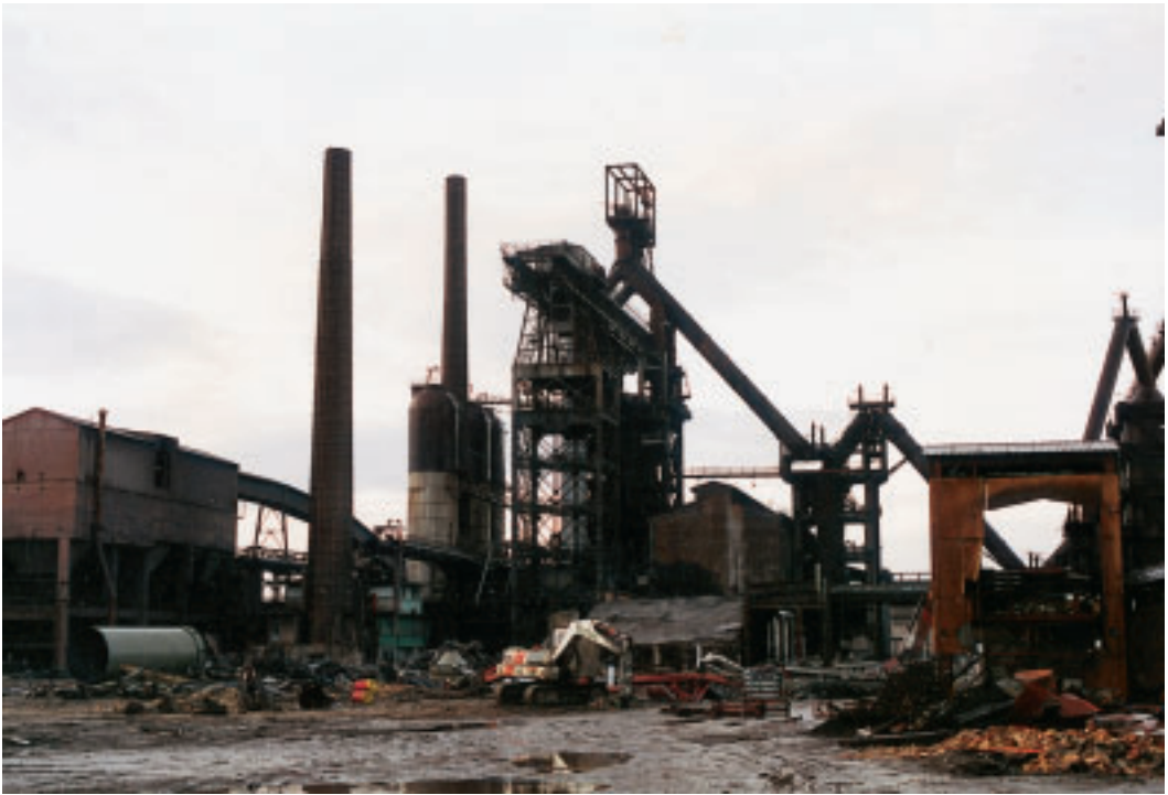
Fig. 1 Haut fourneau U4 d'Uckange, en 1995 ; le site est en cours de nettoyage (cl. J.-L. Tornatore)
