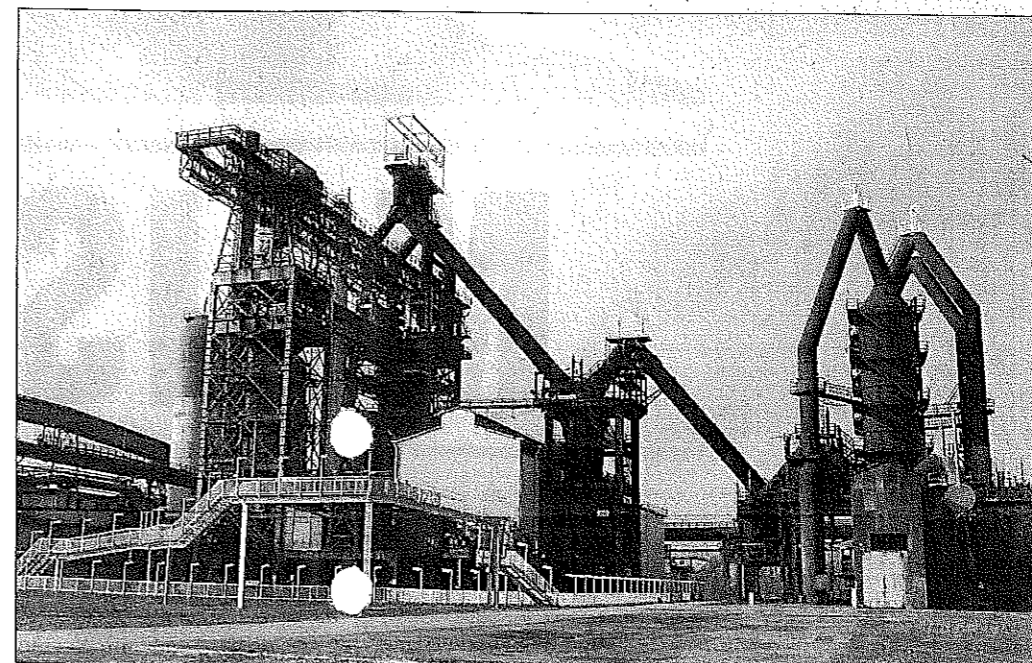
Le haut-fourneau U4 d'Uckange et, à droite les colonnes d'épuration des gaz.
