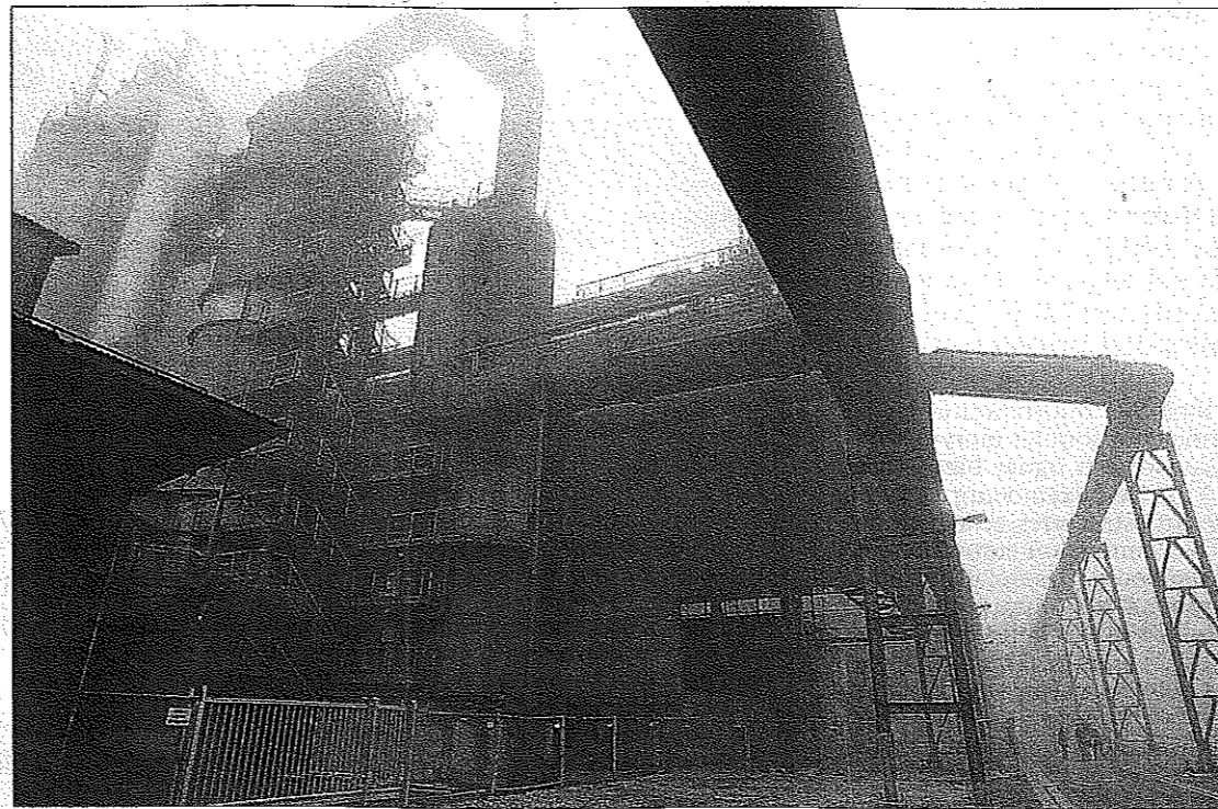
Les défenseurs des hauts fourneaux craignent que certaines structures ne passent à la trappe
